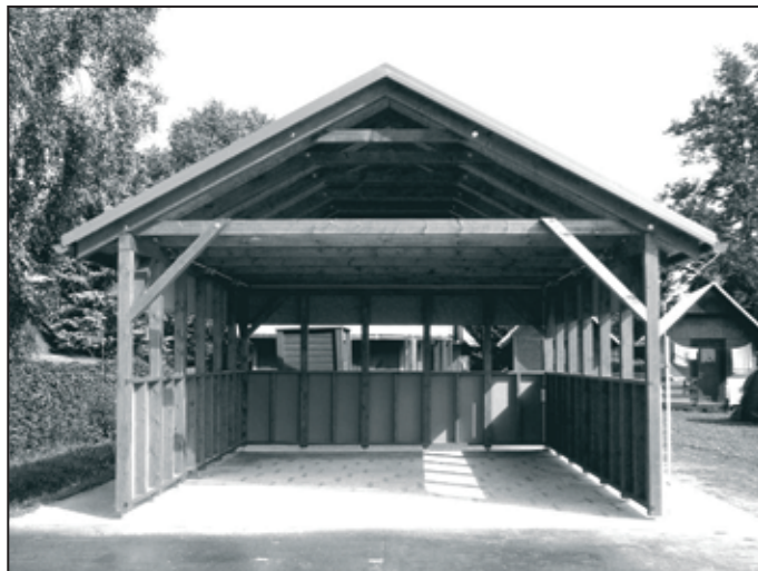
Začátkem července byla v areálu ZŠ a MŠ Osečná postavena nová venkovní učebna
