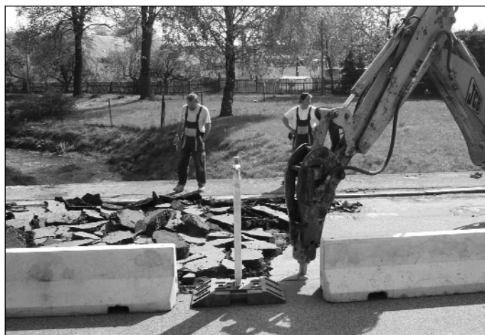
Oprava silnice a mostu. Pátek 24.04.09
